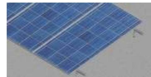
**9** Posicione os dois clamps intermediários e em seguida o módulo seguinte, faça o alinhamento e fixe-os. Faça este processo para os demais módulos, sempre certificando-se do correto posicionamento e fixação dos clamps.
