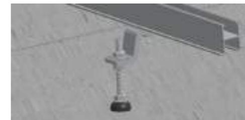
**8** Com os trilhos devidamente instalados, inicie o posicionamento do primeiro módulo sobre eles. Faça o alinhamento com a estrutura e fixe-o utilizando os dois clamps finais, apertando os parafusos com uma chave de boca 13mm ou uma parafusadeira.
